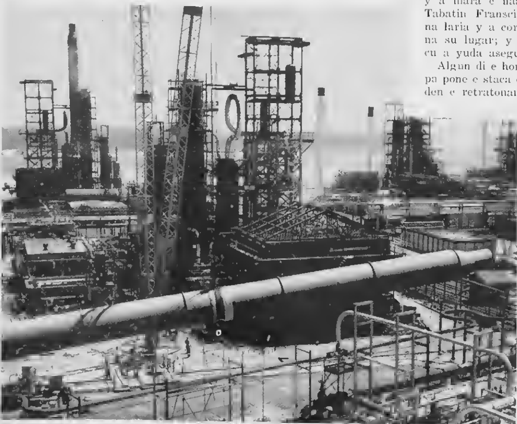
CUMINZAMENTO DI HISAMENTO
